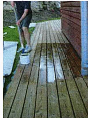
3.1: Når Sioo:x Træbeskyttelsen Grunder har tørret i mindst 4 timer, påføres Sioo:x Vejrbeskyttelse Færdigbehandling.
