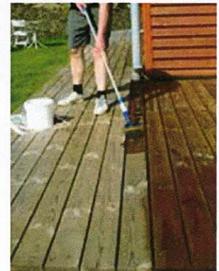
2.1: Efter træet er tørt, påføres Sioo:x Træbeskyttelse Grunder 2 gange.
